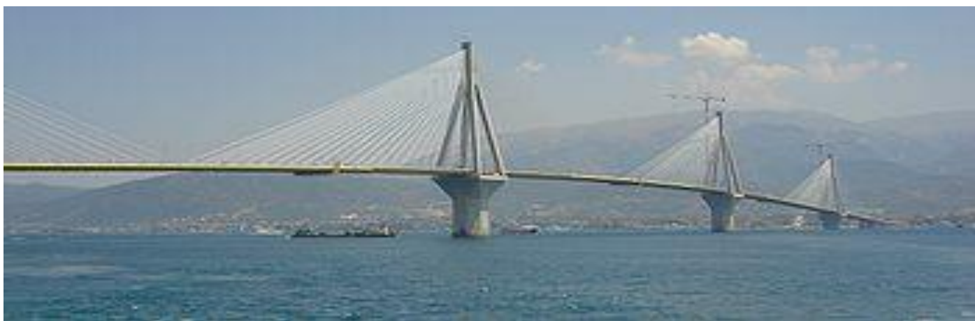
Καλωδιωτή Γέφυρα του Ρίου-Αντιρρίου
