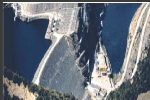
Το φράγμα Σφηκιάς
