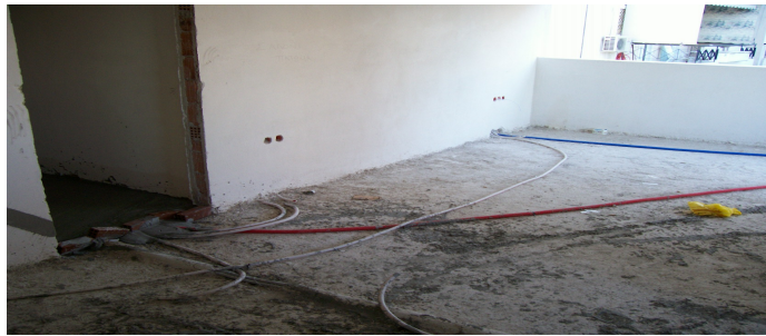
Εικόνα 16: Σωλήνες SiBi coubri για τις οδεύσεις UTP σε αφρομεπετό πριν τοποθετηθούν τα πλακάκια δαπέδου.
