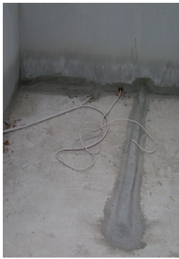
Εικόνα 16: Σωλήνες SiBi coubri για τις οδεύσεις UTP σε αφρομεπετό πριν τοποθετηθούν τα πλακάκια δαπέδου.
