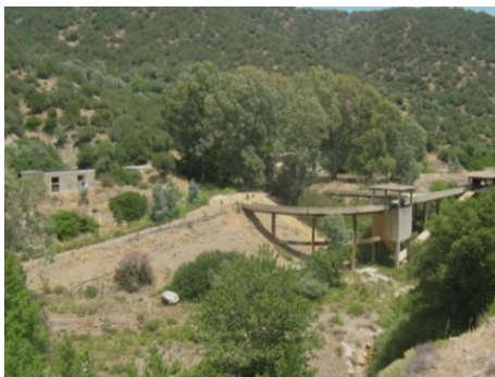
Εγκαταστάσεις στη θέση Ρο ρο
