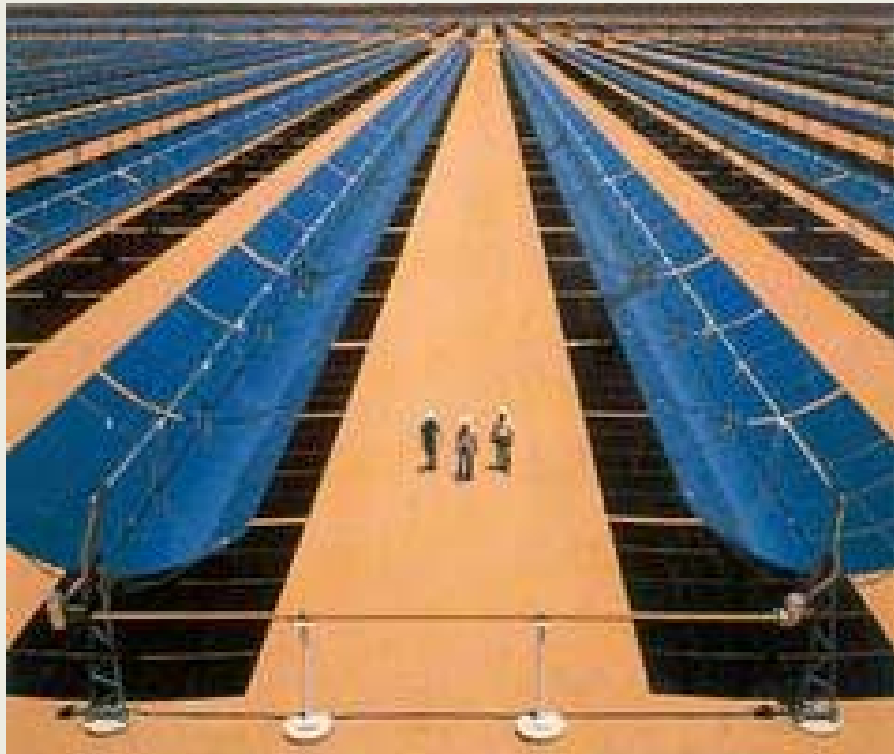
Ηλιακός σταθμός Συγκρότημα ηλιακής ενέργειας στην έρημο Μοχάμπε των Η.Π.Α. Παράγει ηλεκτρισμό με κάτοπτρα που ελέγχονται με ηλεκτρονικό υπολογιστή.
