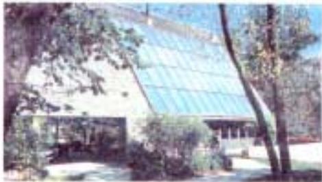
Σχ. 10-26. Συλλέκτης ενός ενεργού ηλιακού συστήματος θερμότητας προσανατολισμένα προς τη Νότιο. Οι επίπεδοι συλλέκτες θερμαίνουν αέρα, ο οποίος μεταφέρεται από αγωγούς όπου χρειάζεται με αντλίες.
