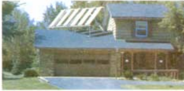
Σχ. 10-43. Συλλέκτες με παραβολικό αυλάκι τοποθετημένοι σε κάποιο σπίτι, "παρακολουθούν" τον ήλιο. Στερεωμένοι στη νότια πλευρά της αράχης παρέχουν ζεστό νερό.
