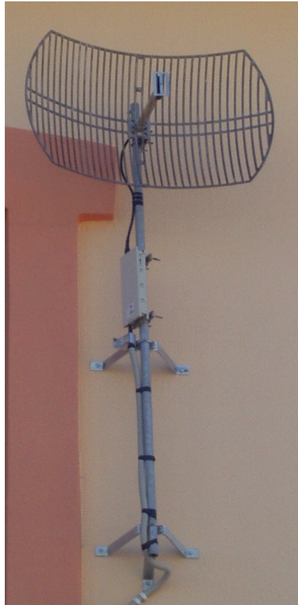
Εικόνα 5-5. Κατευθυντική κεραία εγκατεστημένη σε τερματικό κόμβο.
