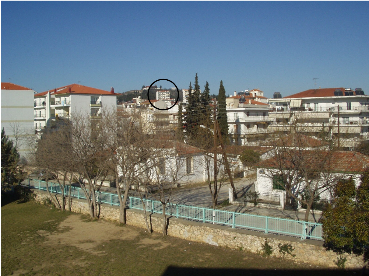
Εικόνα 5-3. Το κτίριο όπου εγκαταστάθηκε ο κεντρικός κόμβος του δικτύου.
