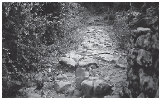
Λιθόστρωτος δρόμος (Καλντερίμι) στο Δίκαστρο
