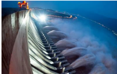
Εικ.4 Υδροηλεκτρικό φράγμα
