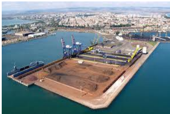
ΕΙΚ.3 ΛΙΜΕΝΑΣ ΦΟΡΤΟΕΚΦΟΡΤΩΣΗΣ
