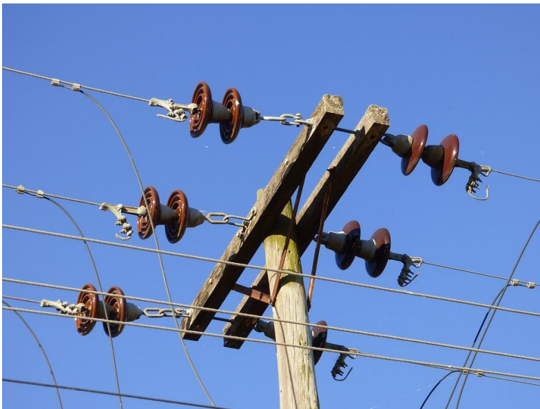
Εικόνα 3: Στα δίκτυα Μεταφοράς και Διανομής της Ηλεκτρικής Ενέργειας παρατηρούμε τη χρήση μονωτήρων, δηλαδή διατάξεων που χρησιμοποιούνται για την απομόνωση των ηλεκτροφόρων στοιχείων μιας ηλεκτρικής εγκατάστασης από τα μη ηλεκτροφόρα.
