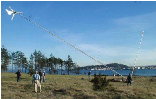
Σχήμα 4. Εγκατάσταση Α/Γ σε πύργο ο οποίος παίρνει την τελική του θέση ώστε να τεθεί το σύστημα σε λειτουργία.
