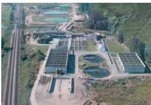
Το νερό από το εργοστάσιο βιολογικού καθαρισμού μπορεί να χρησιμοποιηθεί για άρδευση.
