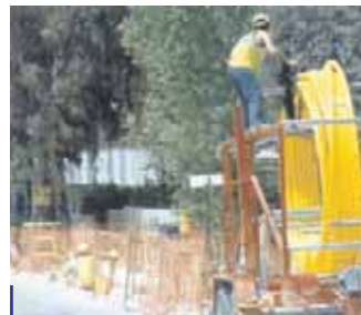
Τοποθέτηση αγωγού φυσικού αερίου
