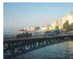
Η μεταλλική γέφυρα που συνδέει τη Στερεά Ελλάδα με την Εύβοια στη Χαλκίδα
