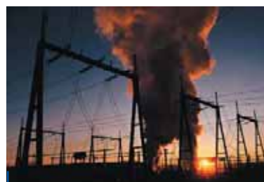
Θερμοηλεκτρικό εργοστάσιο παραγωγής ενέργειας
