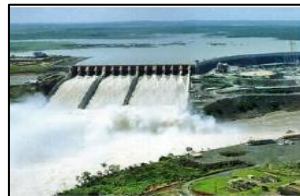
Εικόνα Γ: Υδροηλεκτρικός σταθμός
