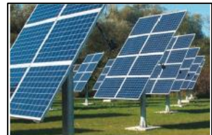
Εικόνα Δ: Φωτοβολταϊκό πάρκο
