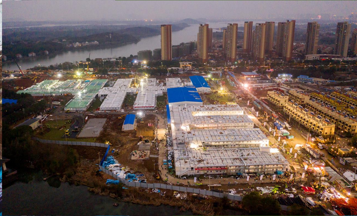
Εργοτάξιο νοσοκομείου στην Κίνα
