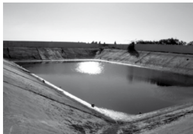
Εικόνα 18: Λεκάνη τεχνητού εμπλουτισμού. Εν λειτουργία σύστημα λεκανών εμπλουτισμού του υπόγειου υδροφόρου συστήματος της περιοχής Hammamet Τυνησίας με την εκροή από μονάδα βιολογικού καθαρισμού σε παρακείμενο οικισμό (σύστημα SAT) για αρδευτικούς σκοπούς κατάντη (Πηγή Μαρίνος, κ.ά., 2008).
